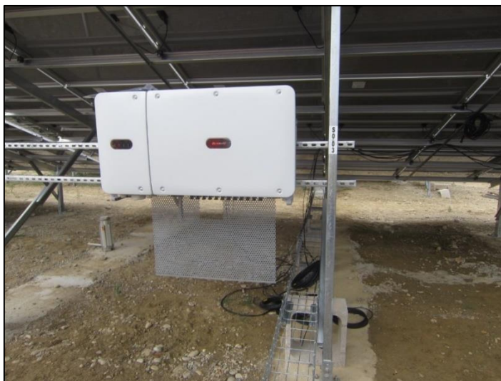
Illustration 53 : Exemple d'onduleur décentralisé
