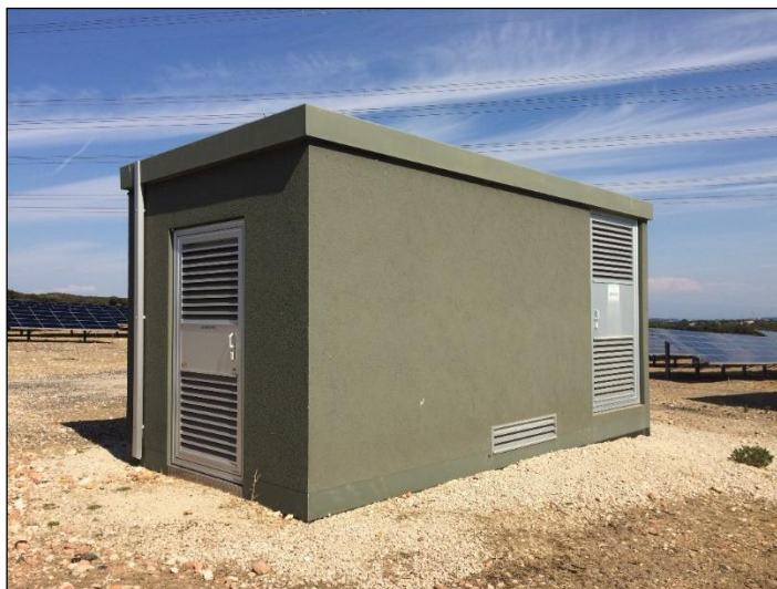
Illustration 52 : Exemple de poste de conversion « indoor »
