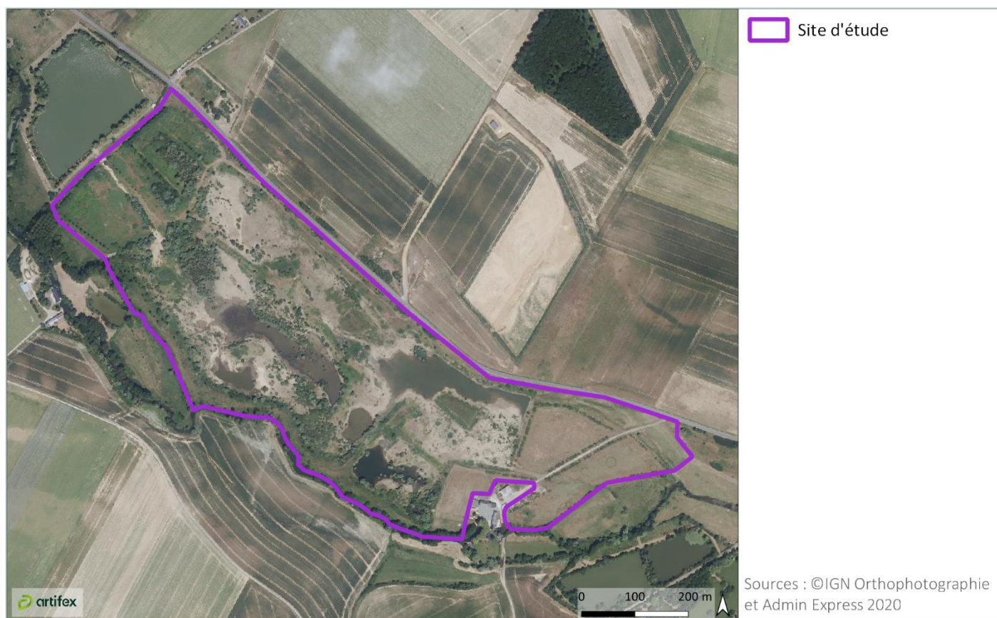
Illustration 9 : Vue aérienne du site d'étude Réalisation : Artifex 2022
