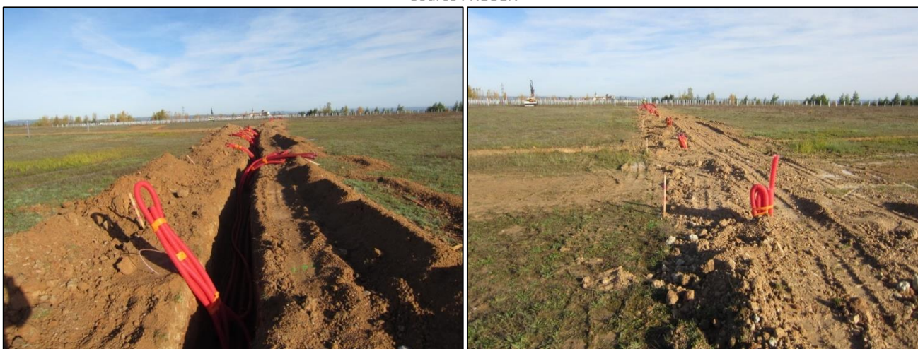
Illustration 57 : Exemple de tranchée et pose de câbles dans des fourreaux
