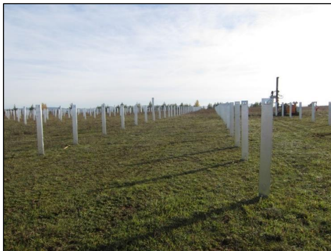
Illustration 58 : Exemple de pieux battus dans le sol avec une batteuse visible en arrière-plan
